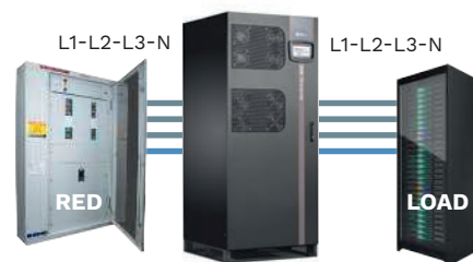
instalación de 4 conductores (L1-L2-L3-N)
